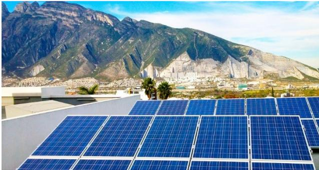
Un panneau solaire est constitué de millions de cellules photovoltaïques. Ces cellules sont des ensembles fermés de silicium qui captent la lumière pour la transformer en énergie électrique.
