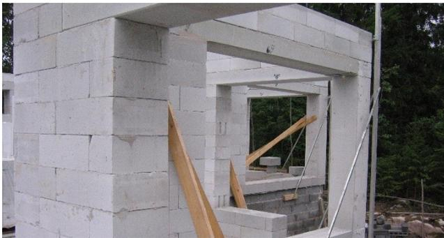
Le béton cellulaire est un matériau de construction. Ce béton est un bon isolant car il renferme des millions de petites poches fermées remplies d'air (les cellules).
